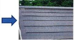
劣化が進んでいる屋根には高 圧洗浄した後に再塗装します。 ※遮熱塗料を使用して小屋 裏の熱量を抑えるの為おスス メの商品です。
