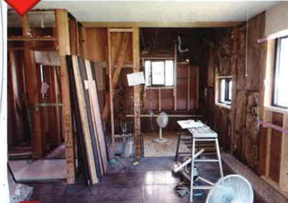
目線② 畳と間仕切壁を撤去します。
